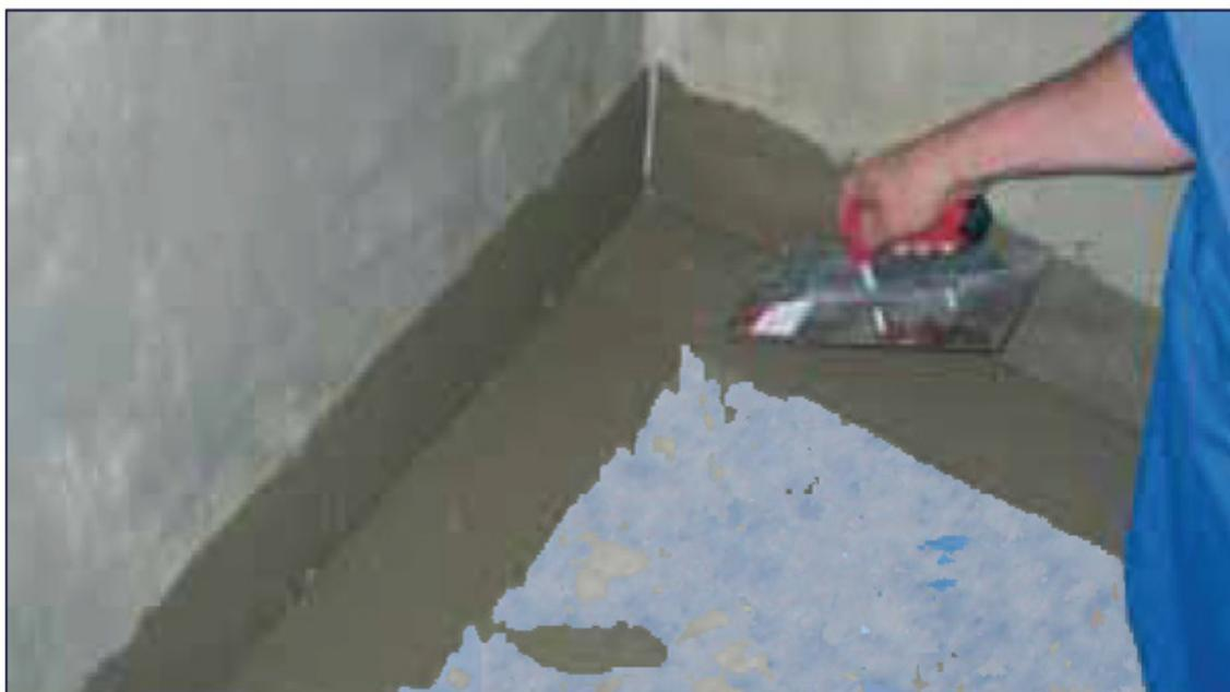
**Utilizar una llana dentada de 4 mm y cemento cola clase C-2**
