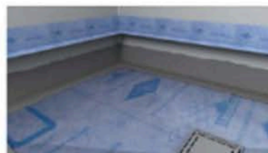
Peinar el perímetro con cemento cola C2
